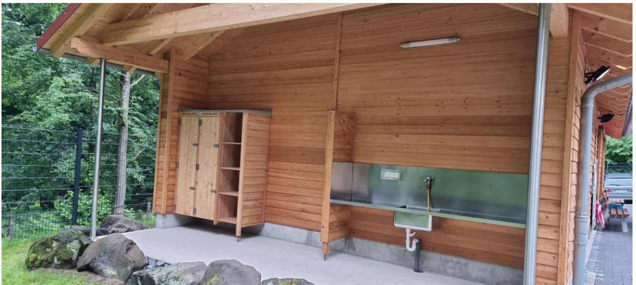
Die Feldküche mit Vorratsschrank unter dem südlichen Giebel.
