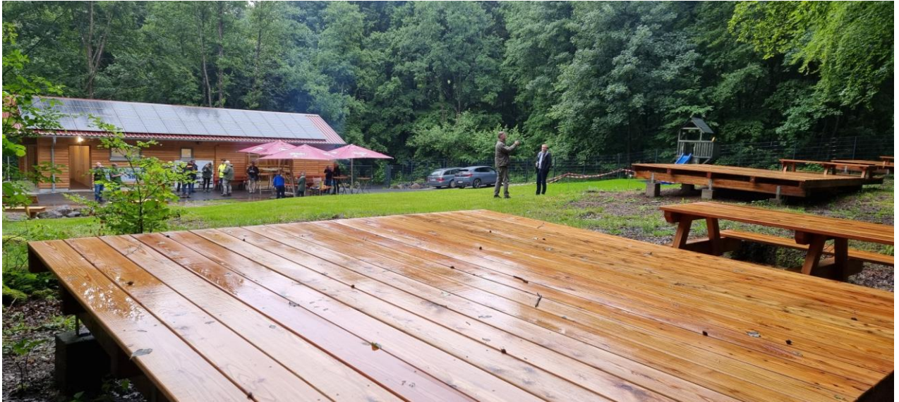
Die neue Freizeitanlage Strutt. Im Vordergrund drei Trecking-Podeste, jeweils mit Bank-Tisch-Garnitur
