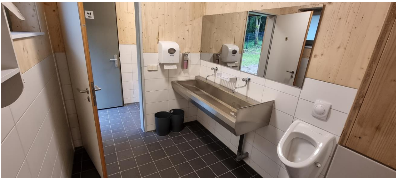
Die WC-Anlage für Herren
